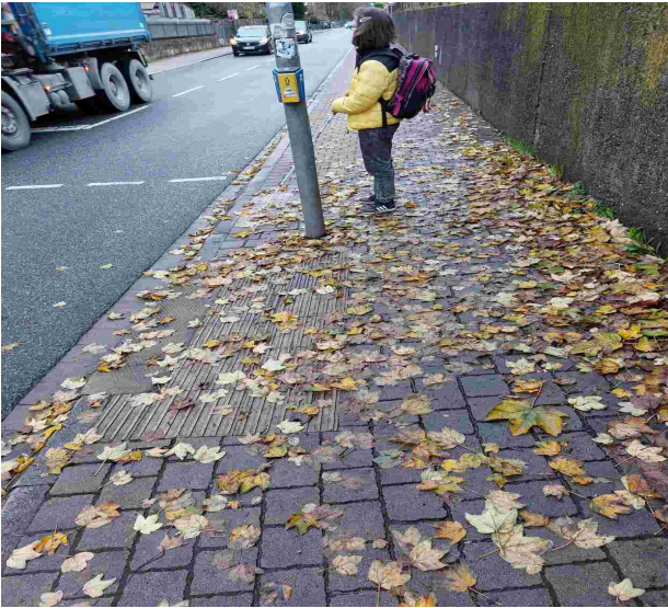
Abbildung 2: Nullabsenkung und Sperrfeld, Auffindestreifen und Begleitflächen sind mit Laub bedeckt
