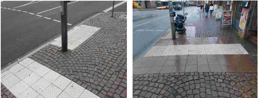
Abbildung 4 & 5: Gehwegbereich mit taktilen Bodenplatten zur Unterstützung von sehbehinderten Personen
